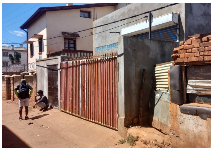
Une nouvelle maison construite juste à côté de notre foyer. Problème: l'autre foyer n'a plus d'accès à la rue.
